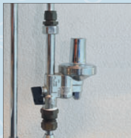
6. Uitloop en tevens overstort aansluiting.
