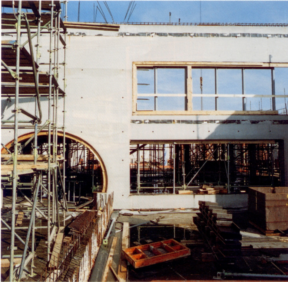
4 | Het resultaat na ontkisten: afwerkingsklasse 1A!
