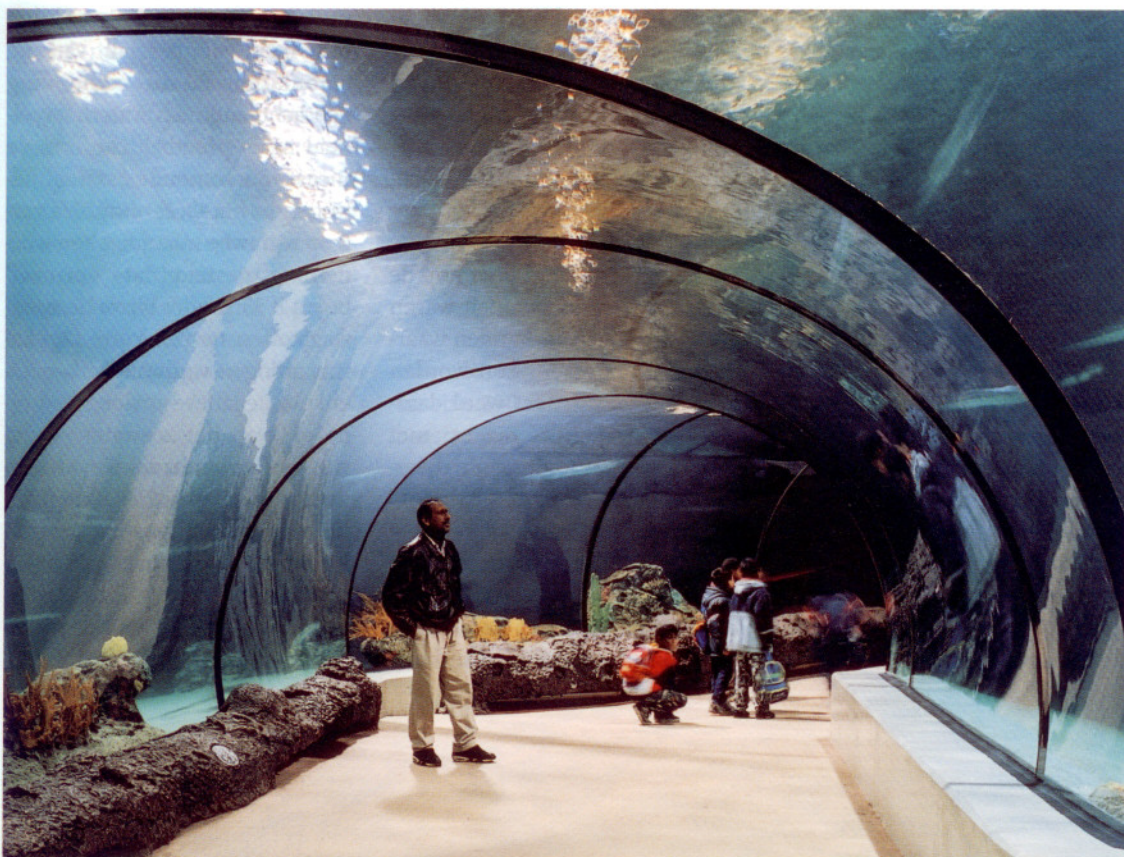
2 | Tunnel onder het haaienbassin, uitkomend in de 'grote-gatenwand'. Deze wand gaf aanleiding tot het uiteindelijk groot-schalige gebruik van zelfverdichtend beton
