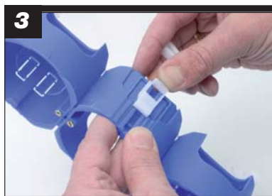
3 Fixraps aan de te koppelen zijden van de HW51-F verwijderen. Het is overigens aan te bevelen bij drie gekoppelde dozen de middelste doos om te draaien.
