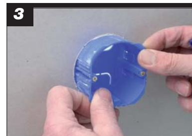
3 De doos uitnemen. Voor herplaatsing van de doos nieuwe fixraps tot bovenaan de doos schuiven en de montage instructie hervatten vanaf afbeelding 2.
