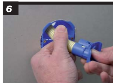
6 Flexibele buis tot gewenste lengte afkorten, in tuit drukken.
