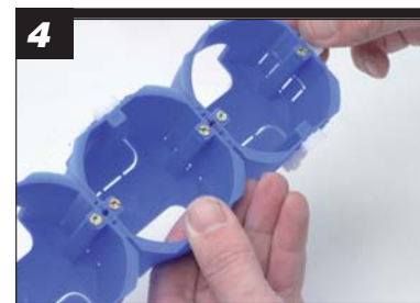
4 Hollewanddozen aan elkaar koppelen en extra fixraps tot boven aan de doos schuiven. Vervolgens combinatie dozen in zijn geheel in de wand plaatsen.
