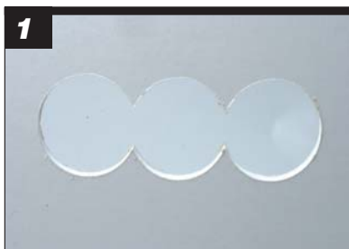
1 Centerpunten van hollewanddozen aftekenen (hartafstand 71mm), gaten boren van Ø 76mm.
