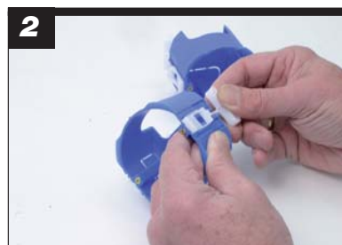
2 Fixraps aan de te koppelen zijden van de HW51-F verwijderen.
