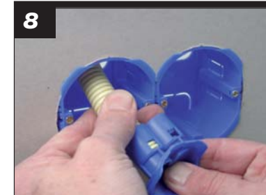
8 Buis in tuit drukken en dit geheel in de doos bevestigen.
