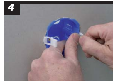
4 Fixraps aantrekken tot deze stevig vastzitten.
