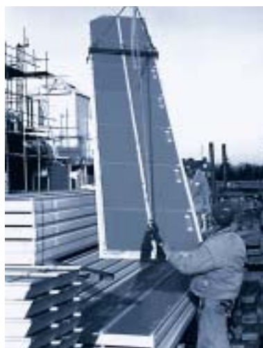
Met de hijsinrichting worden lichamelijke inspanningen op het dak tot een minimum beperkt.
