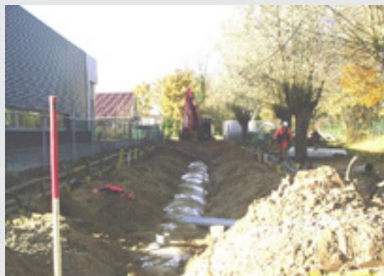
De sleuf is bijna aangevuld
