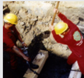
Aanbrengen van polystyreen stroken
