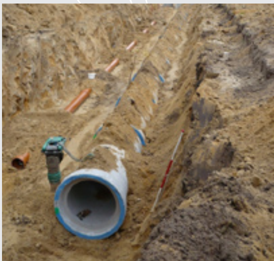
Het gefaseerd aanvullen van de sleuf
