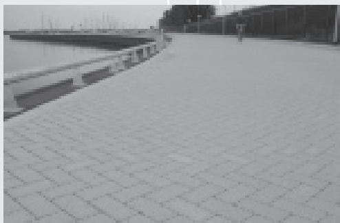
Waterpasserende verharding: een voorbeeld van meervoudig ruimtegebruik
