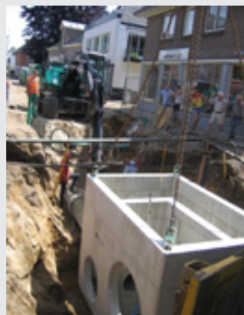
Montage van een overstortput
