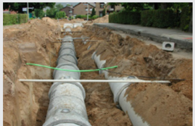
Buizen met de huisaansluitingen aan de bovenzijde
