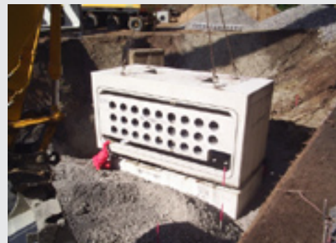
Het plaatsen van een diffusiewand
